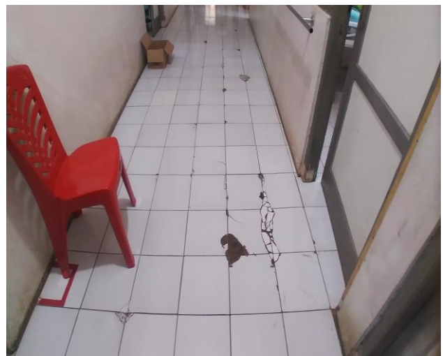
Jalan Koridor Rawat Inap (Lantai sudah pecah-pecah dan ada lantai amblas)
