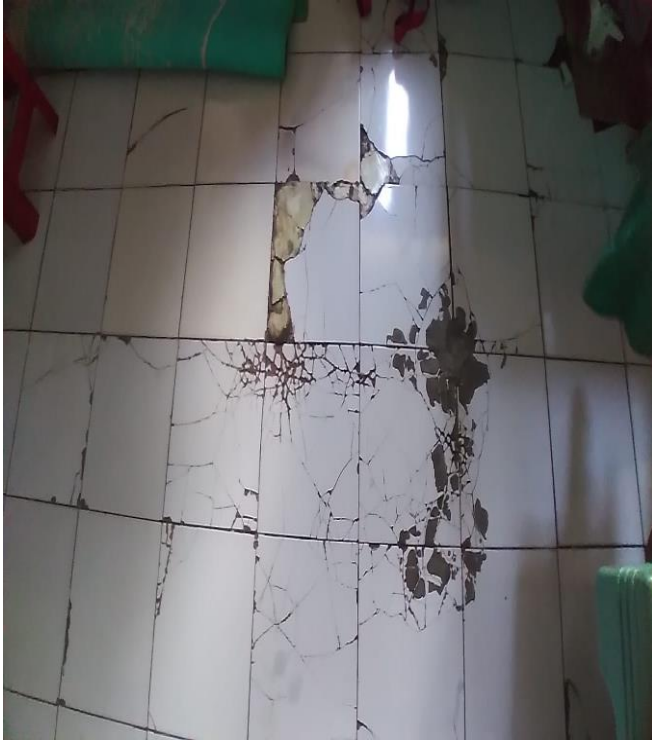
Lantai dalam Ruang Pasien Rawat Inap (Lantai Pecah-Pecah)
